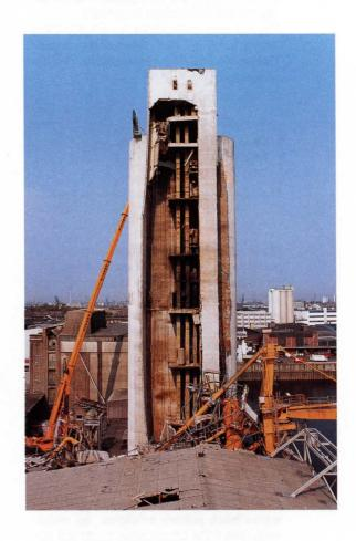
worden. Große Betonbrocken hatten in einem Umkreis von bis zu 30 m insbesondere die Dächer der benachbarten Gebäude stark beschädigt.
