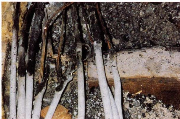
Isolationsfehler an elektrischen Leitungen aufgrund mechanischer Überbeanspruchung
