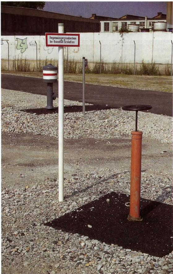
Lager für Sonderabfälle mit flüssigkeitsdichtem Bodenbelag und Löschwasserkanalisation
