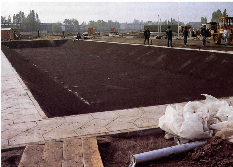
Auffangbecken für kontaminiertes Löschwasser eines Lagers für Sonderabfälle
