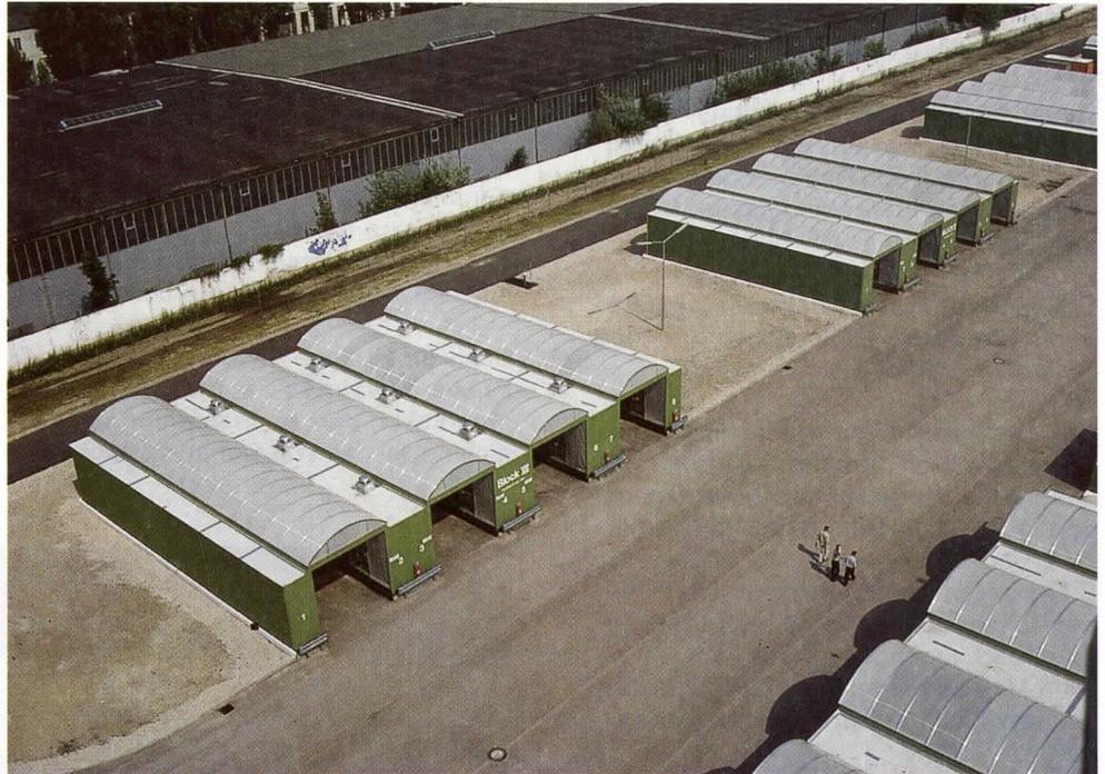
Lager für Sonderabfälle mit flüssigkeitsdichtem Bodenbelag und Löschwasserkanalisation
