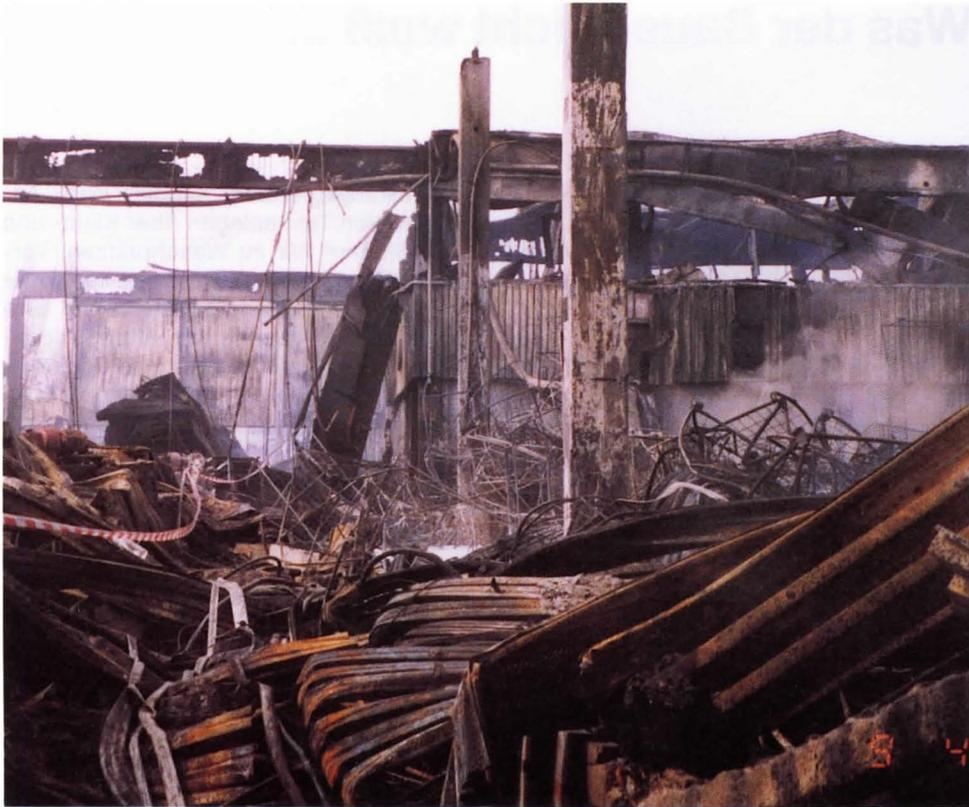
Der Blick auf den Schadenentstehungs-ort zeigt das Ausmaß der Zerstörung. Die noch vorhandenen Stahlbetonbinder sind durch die thermische Belastung regelrecht durchlöchert.
