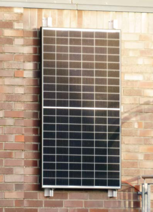
Bild 4 / Wandmontage eines PV-Moduls
