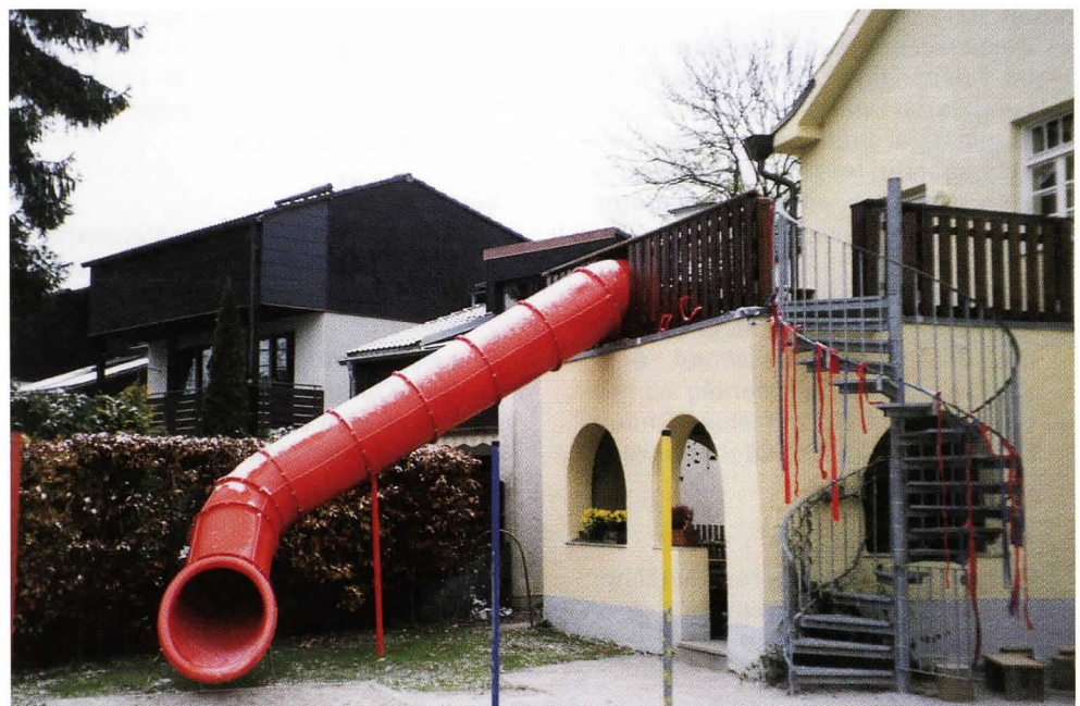
Rutsche aus GFK (Glasfaserkunststoff), hier als Spielgerät neben einer steilen Fluchttreppe. Kindergarten „Villa Kunterbunt“ – 82194 Gröbenzell
