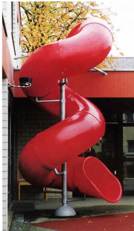
PE – Wendelrutsche hier mit Fallschutzboden nach Euronorm. Evangelischer Johannes Kindergarten in 68782 Brühl-Rohrdorf.
