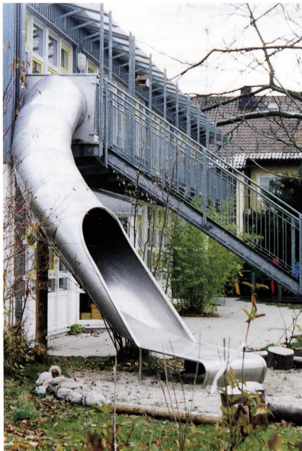
Edelstahlrutsche neben herkömmlicher, steiler Fluchttreppe. Evangelischer Zachäus Kindergarten – 82194 Gröbenzell
