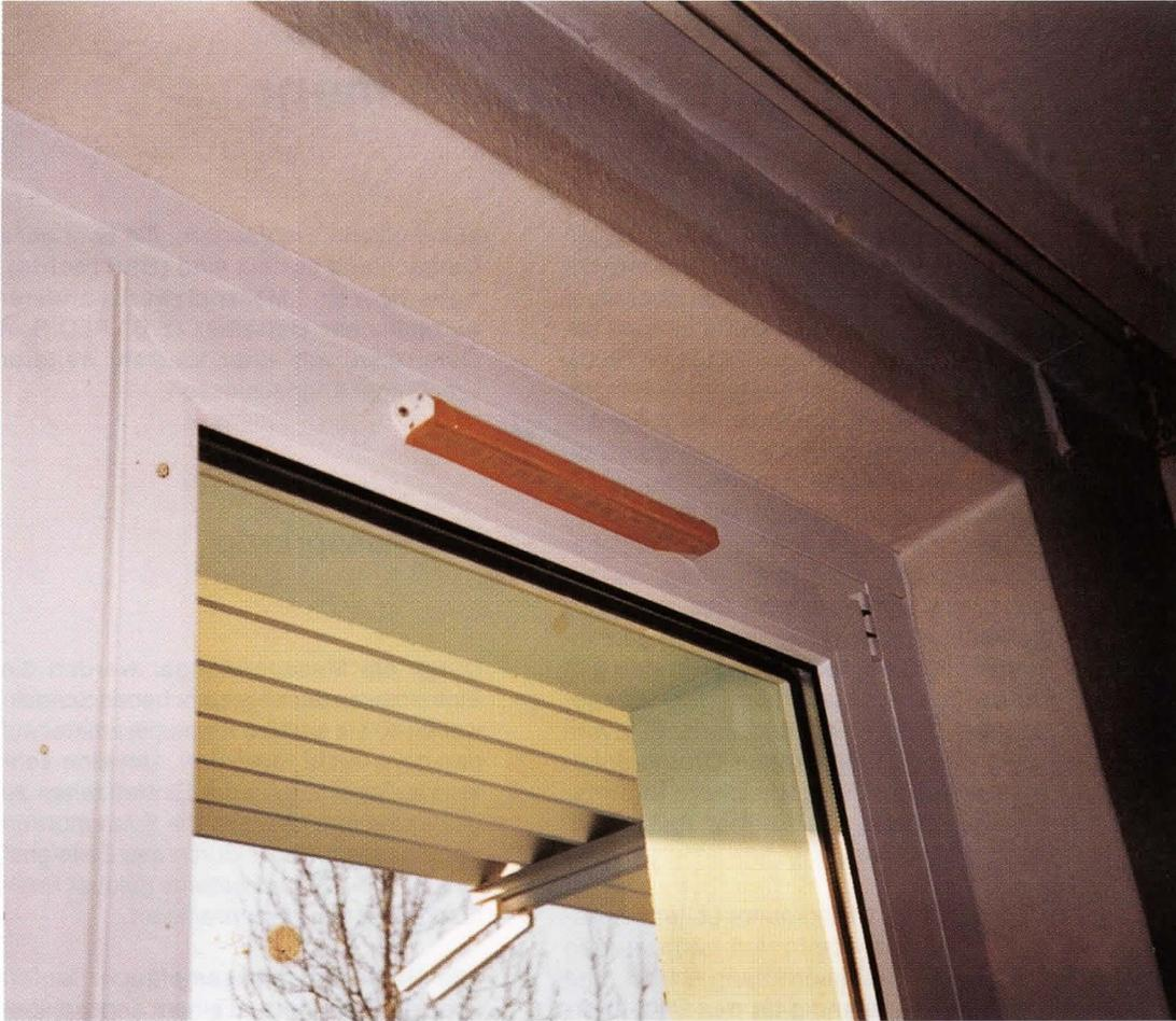
**Bild 7:** Fenster mit vorbildlichem Aussenluftdurchlass zur Gewährleistung der Anforderungen an Raumhygiene und Bauphysik. Von vielen Fachleuten unterschätzt – der hygienisch erforderliche Luftwechsel ist immer größer als der technologisch erforderliche Luftwechsel für eine raumluftabhängige Gas-Etagenheizung.
