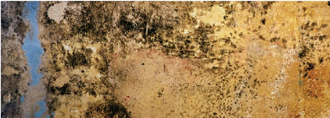
**Bild 6:** Großflächiger Befall nach Lösch- und Regenwassereinbruch.
