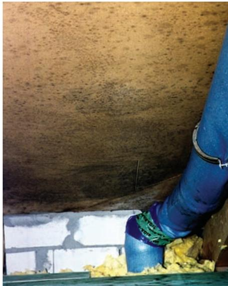
**Bild 3:** Stark befallene Holzfaserplatte hinter einer Wärmedämmung ohne Dampfsperre.
