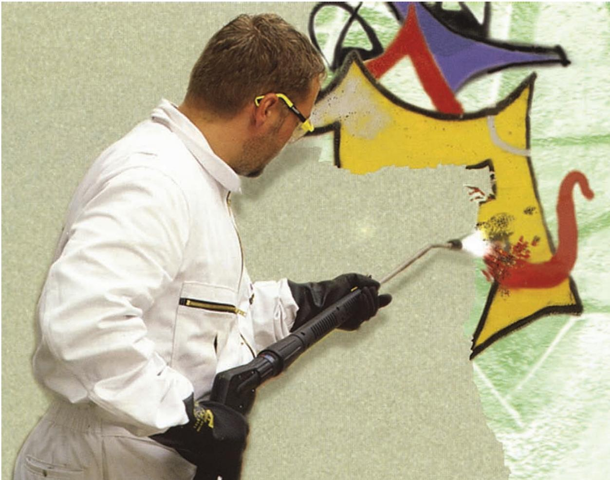
**Bild 1:** Graffiti-Entfernung mit einem Hochdruck-Wasserstrahl
