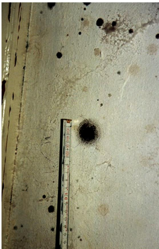
**Bild 2:** Kreisrunde Pilzkolonien an einer stark durchfeuchteten Wand.
