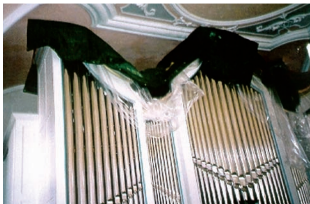
Bild 5: Erste Schadenminderungsmaßnahmen – mit Folien abgedeckte Orgel
