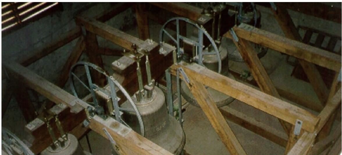
Bild 6: Die neue Eichenholzkonstruktion des Glockenstuhles
