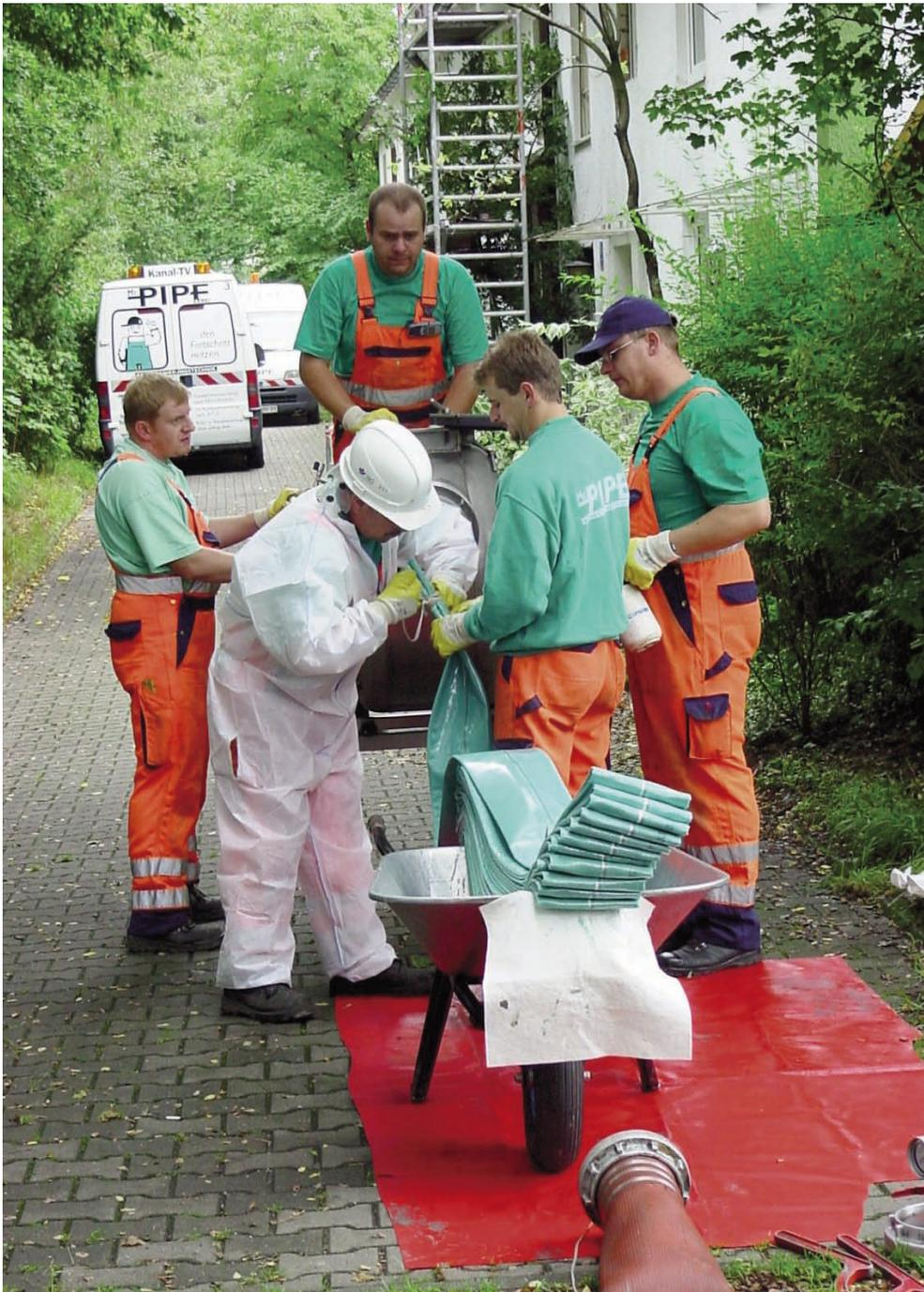
**Bild 3:** Durchführung einer Inliner-Sanierung. Der kunstharzgetränkte Nadelfilzschlauch ist vorbereitet. Er wird durch Luftdruck in das alte Rohr hineingestülpt. Die Folienseite wird zur glatten Innenseite, das Harz schmiegt sich an die Altrohrwandung. Nach dem Aushärten entsteht ein neues, belastungsfähiges Innenrohr.
