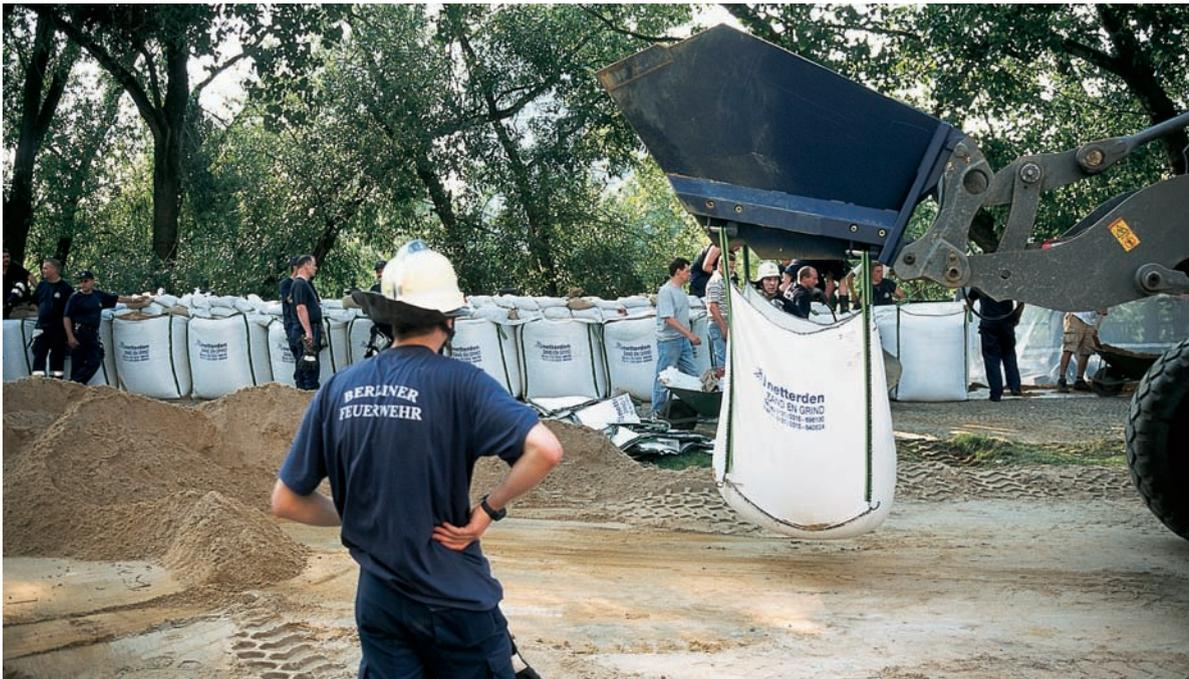
**Bild 2:** Big Bags werden mit Hilfe eines Radladers und einer Füllvorrichtung mit 1m<sup>3</sup> Sand befüllt und an Ort und Stelle platziert.
