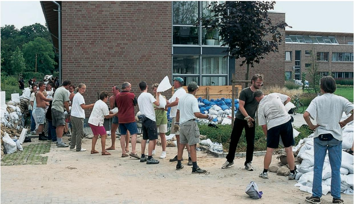
**Bild 6:** Erhöhung der Deiche im Bereich des BUGA-Geländes mit Sandsäcken.
