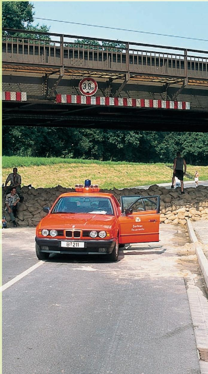
Bild 4: Schließen von Unterführungen
