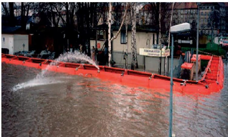
**Bild 1:** Mobiler Hochwasserschutz – Beispiel für einen Ringschutz bei einer Muldenlage der betroffenen Gebäude
