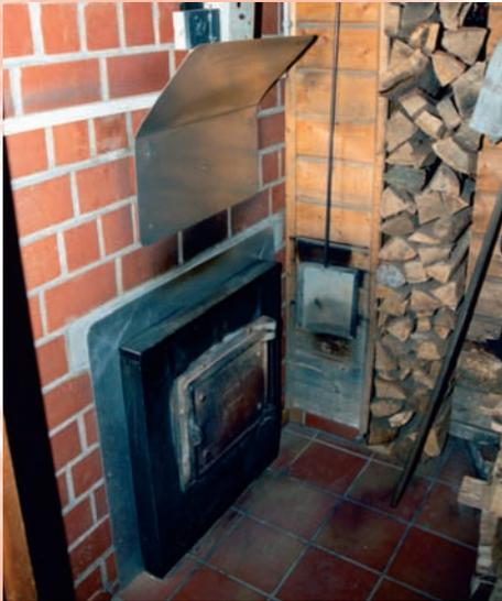
**Bild 4:** Saunaofen mit brandschutztechnischen Mängeln – sicherheitsrelevante Steuerelemente sind durch ein Blech nur unzureichend vor Hitze geschützt. Die Befestigung dieser Steuerelemente mit Kabelbindern ist ebenfalls zu beanstanden.
