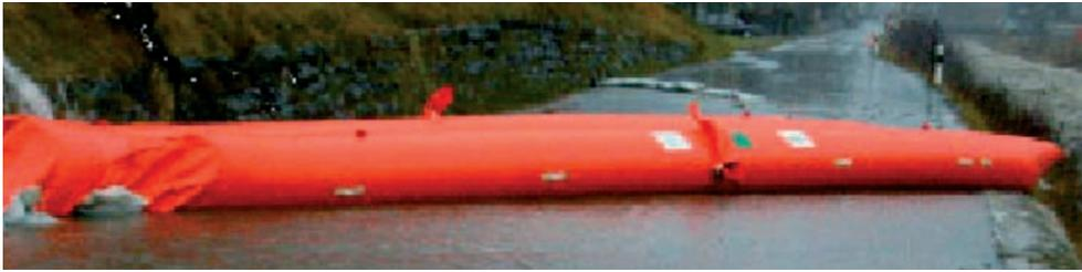
**Bild 2:** Mobiler Hochwasserschutz – Absperrn eines Straßenabflusses
