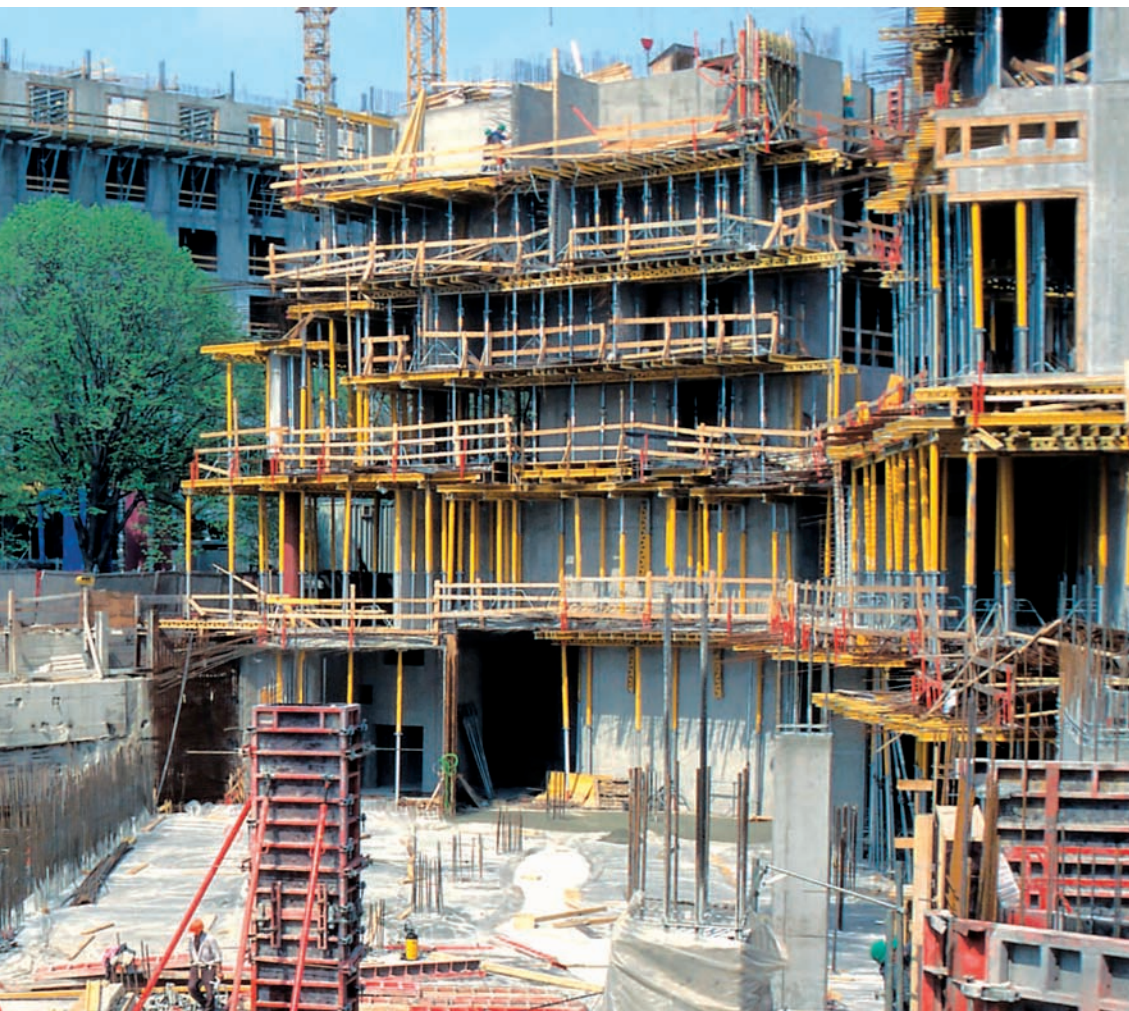
Bild 4: Es gibt drei Verfahrenswege in der Baugenehmigung (§§ 62 - 64), welche die Fachkompetenz der am Bau Beteiligten und ihre mögliche kompetente und verantwortbare Mitwirkung berücksichtigen.
