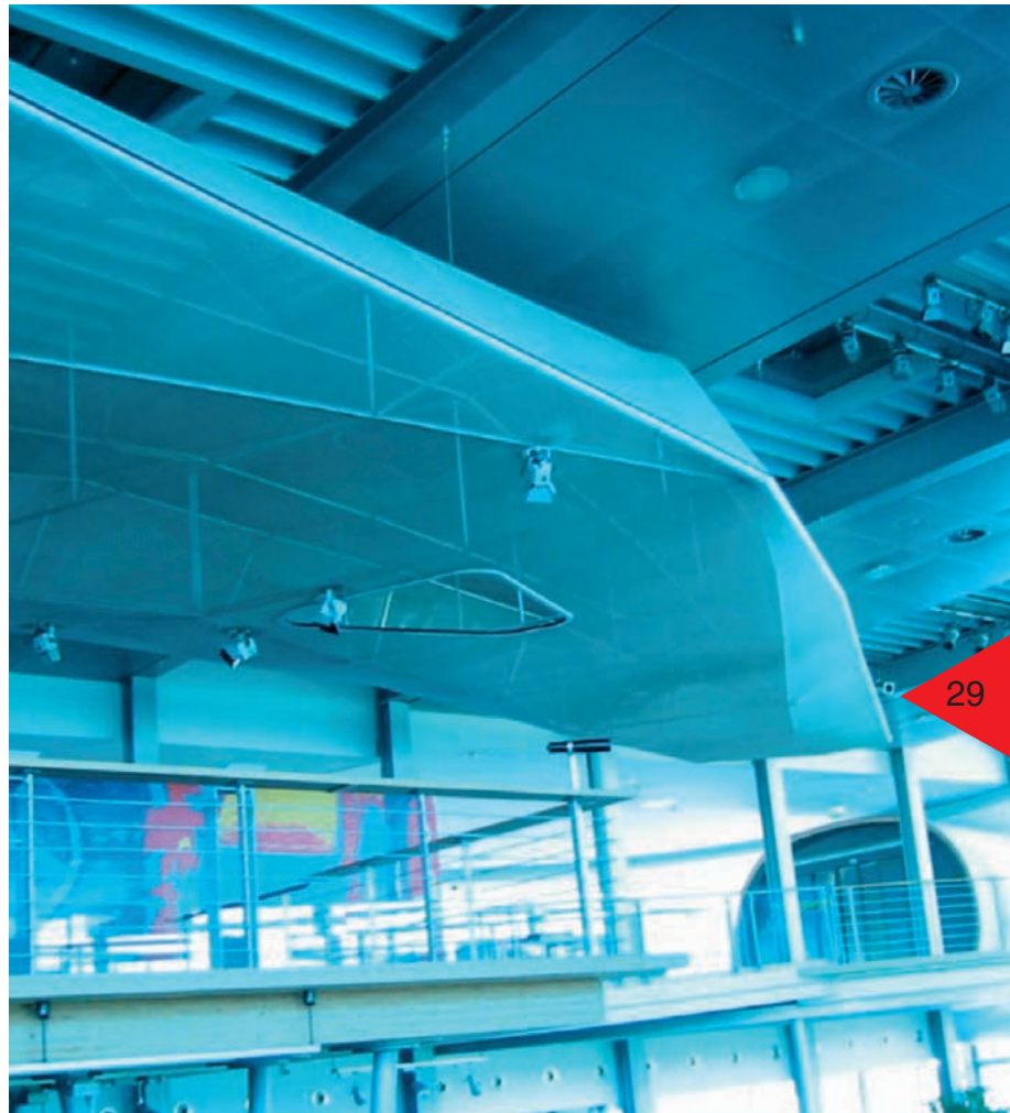
Bild 3: Einsatzbeispiel von nichtbrennbaren Glasgewebe im Messebereich
