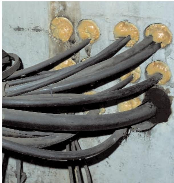
**Bild 3 und 4:** Zahlreiche technische Gewerke durchziehen mit ihren Leitungen Gebäude durch viele Brandabschnitte. Die Schottung zwischen den Abschnitten muss fachgerecht durchgeführt werden, um eine Brandausbreitung zu verhindern. Offene Wand- oder Deckendurchbrüche und ungeeignete Füllmaterialien tragen dazu bei, dass sich Rauch und Feuer unkontrollierbar ausbreiten können. Die Schäden in weiteren, eigentlich nicht betroffenen Bereichen sind vermeidbar.
