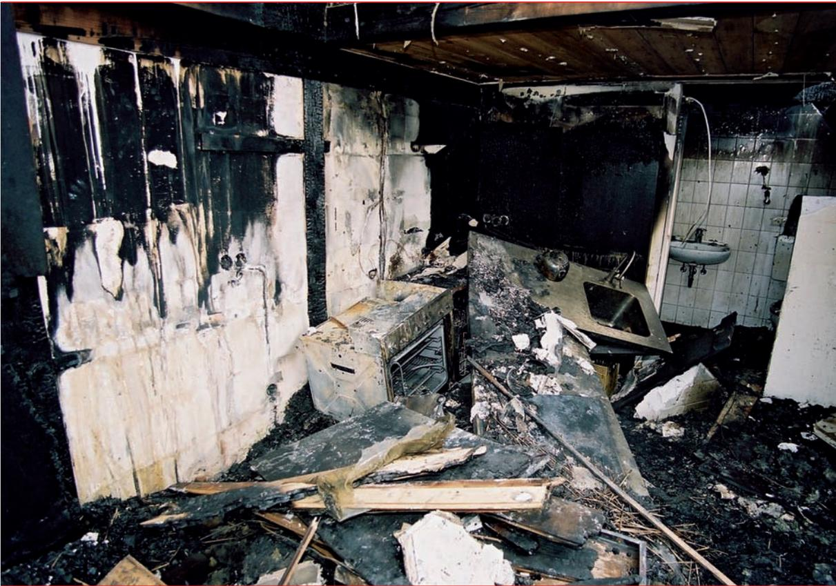
Den Brandausbruch lokalisierte das IFS, das mit der Untersuchung des Falles beauftragt wurde, im Wandbereich einer Einbauküche im Dachgeschoss. Hier waren die Paneele großflächig heruntergebrannt. Der Gutachter fand massive Brandspuren an den elektrischen Leitungen und Blitzeinschlags Spuren in unmittelbarer Nähe des Brandausbruchsortes. Eine detaillierte Blitzauskunft belegte die starke Gewittertätigkeit am Schadentag und Blitzeinschläge in der näheren Umgebung.
