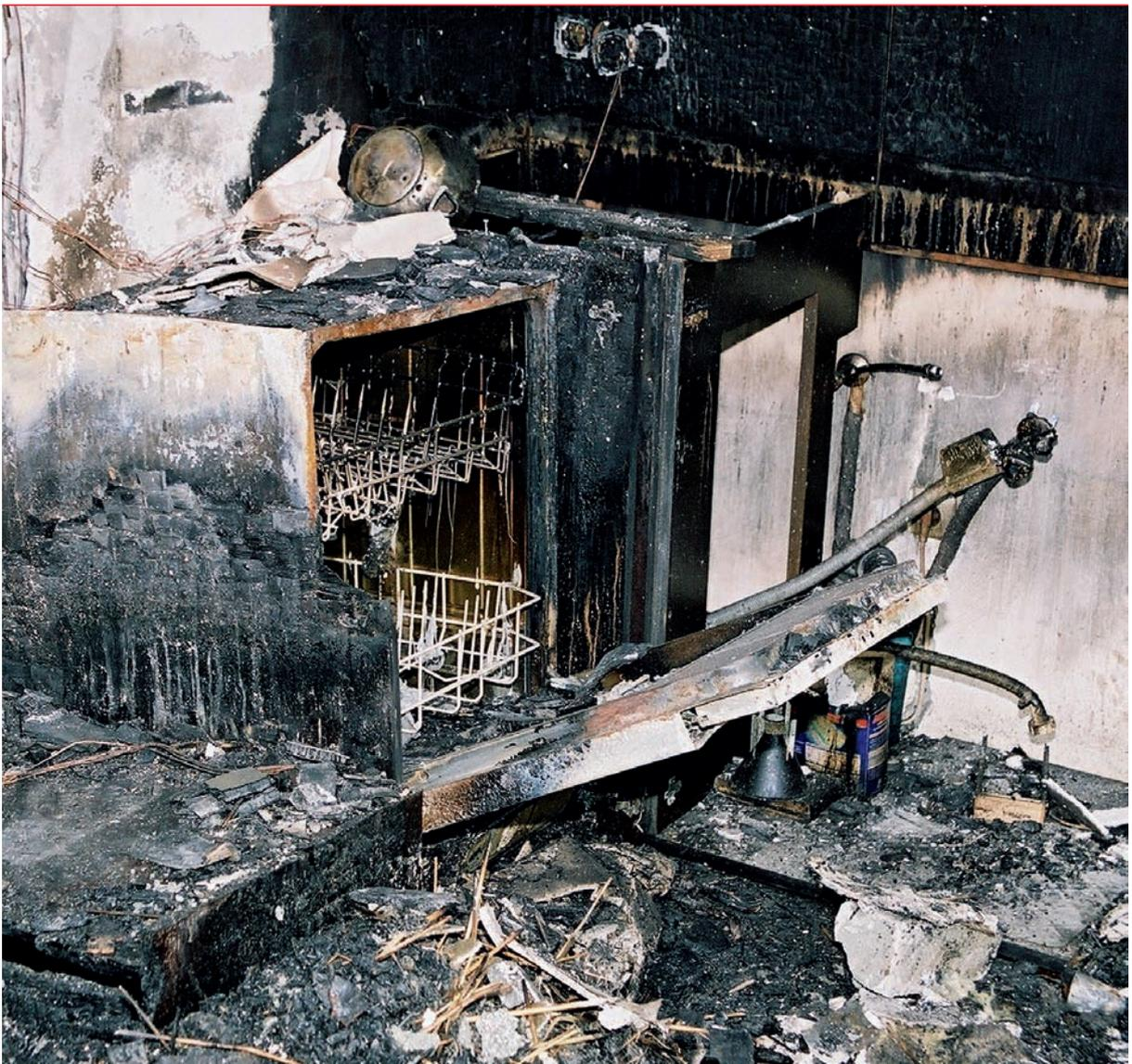
Ursache des Feuers war zweifelsfrei ein Blitzschlag, der einen Defekt und in der Folge einen Brand in der Elektroinstallation der Küche ausgelöst hatte. Von hier aus hatten sich die Flammen über die Wandpaneele auf das Obergeschoss und das Dach ausgebreitet.
