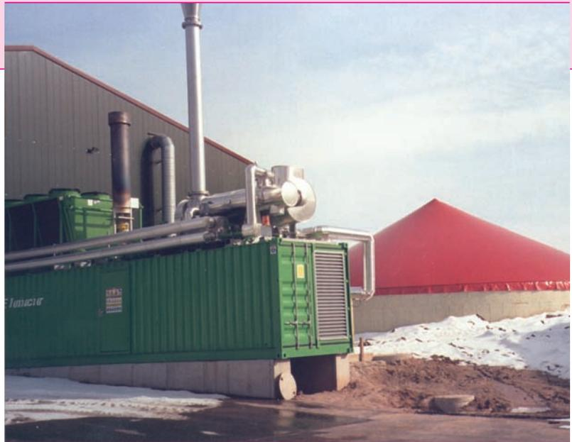
**Bild 7:** Fermenter einer Biogasanlage und Container mit Gasmotoren
