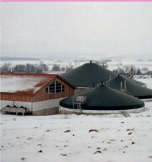
**Bild 8:** Stehende Stahlbetonfermenter und Nachgärbehälter mit Foliendach zur Speicherung des anfallenden Gases
