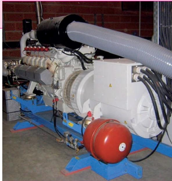
**Bild 9:** Verwertung des erzeugten Biogases in einem Gas-Otto-Motor
