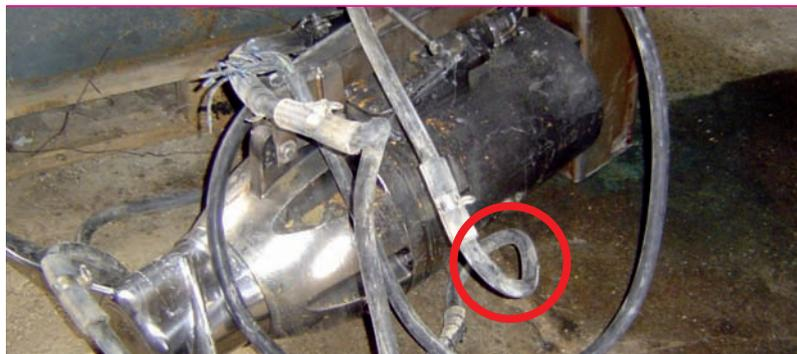
**Bild 14:** Kurzschlusschaden an einem Tauchmotor einer Vorgrube
