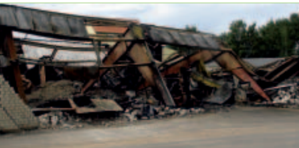
Bild 1: Die Betriebshalle des Recyclingbetriebes wurde durch den Brand vollständig zerstört.
