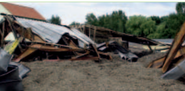
Bild 2: Zum Bekämpfen von Brandnestern wurde das verbliebene Recyclingmaterial teilweise umgeschichtet.
