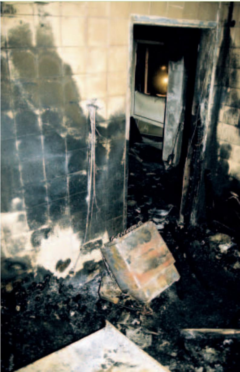
**Bild 5:** Die finnische Sauna ging durch einen falsch installierten Saunaofen in Flammen auf.
