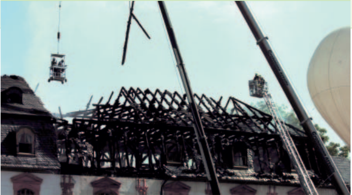
Bild 4: Abbau des Dachstuhls unter Aufsicht der Feuerwehr.
