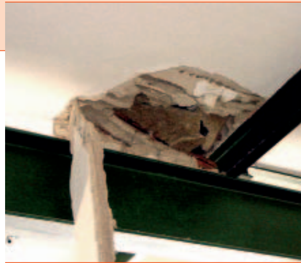
Bild 7 und 8: Pultdachkonstruktion – schwere Ausführungsfehler (Schneedruckschaden wegen konstruktiver Mängel).
