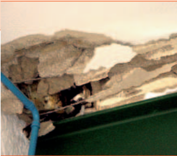
Bild 7 und 8: Pultdachkonstruktion – schwere Ausführungsfehler (Schneedruckschaden wegen konstruktiver Mängel).
