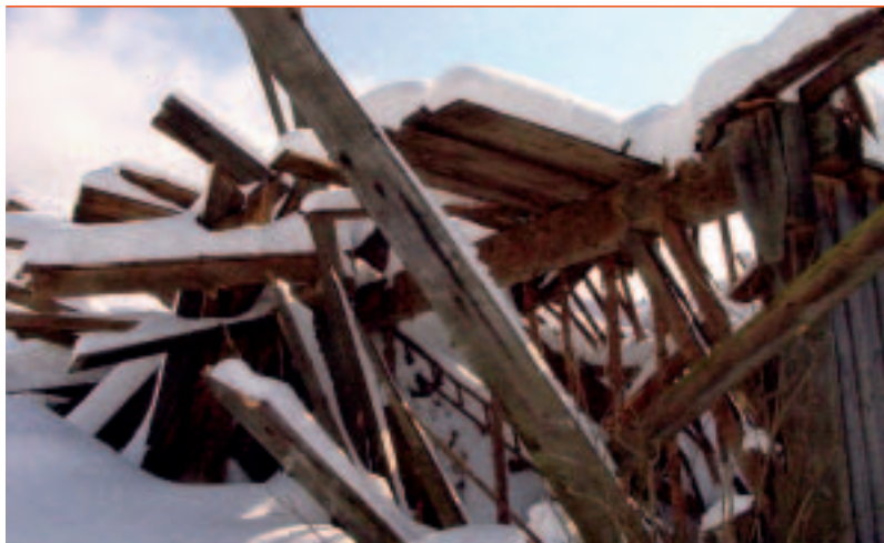
Bild 3 und 4: Landwirtschaftliche Scheune – in herkömmlicher Zimmermannskonstruktion („echter“ Schneedruckschaden).
