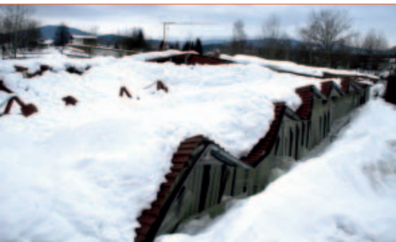
Bild 1 und 2: Stahlskeletthalle – Ausführung mit normgerechter Schneelastannahme („echter“ Schneedruckschaden).
