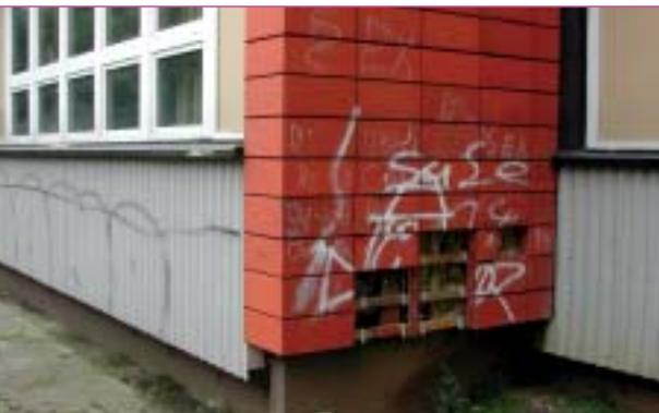
**Bild 1:** Beschädigte Außenisolierung
