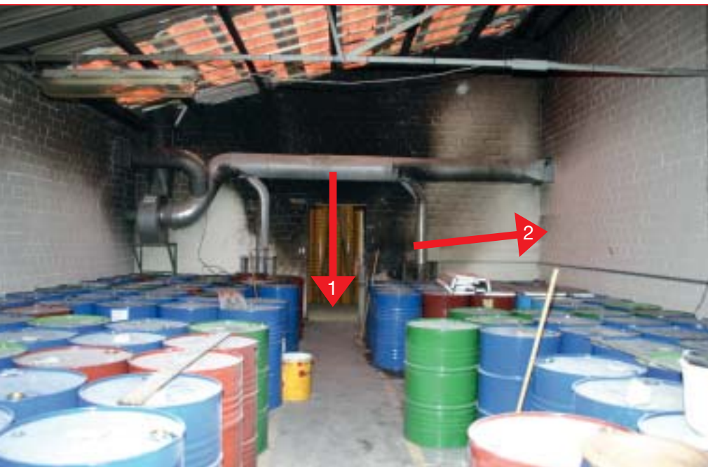
Bild 1: Der Brandschwerpunkt vor der Tür (1) und Rauchgasfahnen an der Wand (2)
