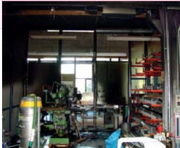
Bild 4: Fräsmaschine und thermisch betroffener Brandbereich
