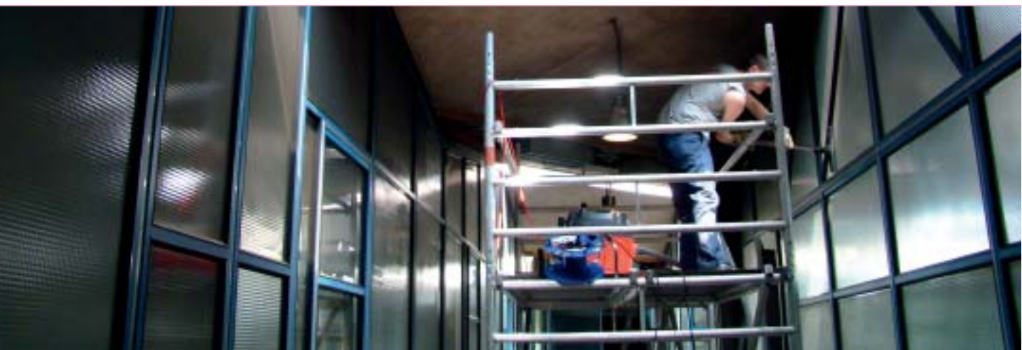
Bild 12, 13 und 14: Betriebsgebäude, Verrußung der Gebäude-Oberflächen
