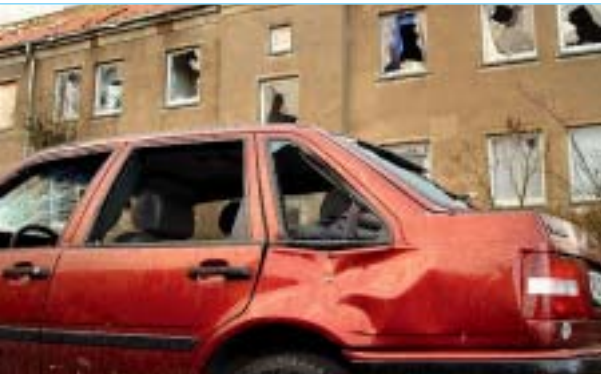
Bild 11 und 12: Schadenbilder nach dem Tornado in der Lutherstadt Wittenberg (Quelle: Lutherstadt Wittenberg)
