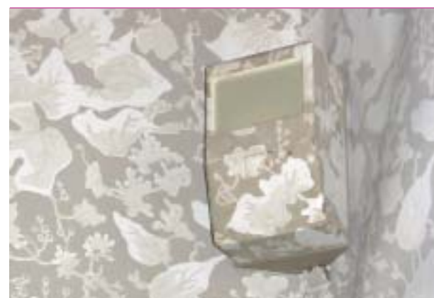
Bild 5: Elektronische Sicherung eines denkmalgeschützten Ausstellungsraumes
