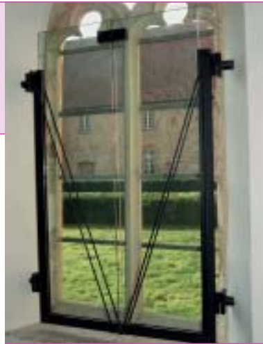
Bild 3: Detailansicht einer Kombination von mechanischer und elektronischer Sicherung
