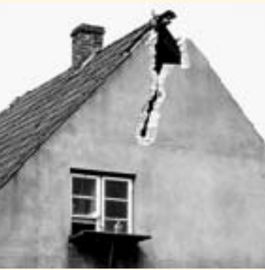
Bild 1: Beschädigter Giebel
