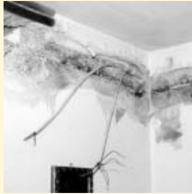
Bild 2: Herausgesprengte Elektroinstallationsleitung
