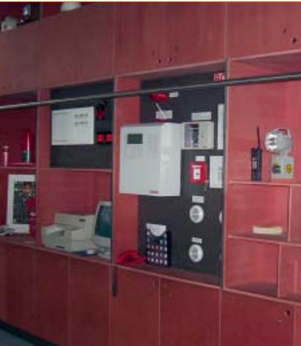
Bild 4: An dieser Wand erfahren Besucher die Funktionsweise einer Brandmeldezentrale oder lernen, einen richtigen Notruf abzusetzen.
