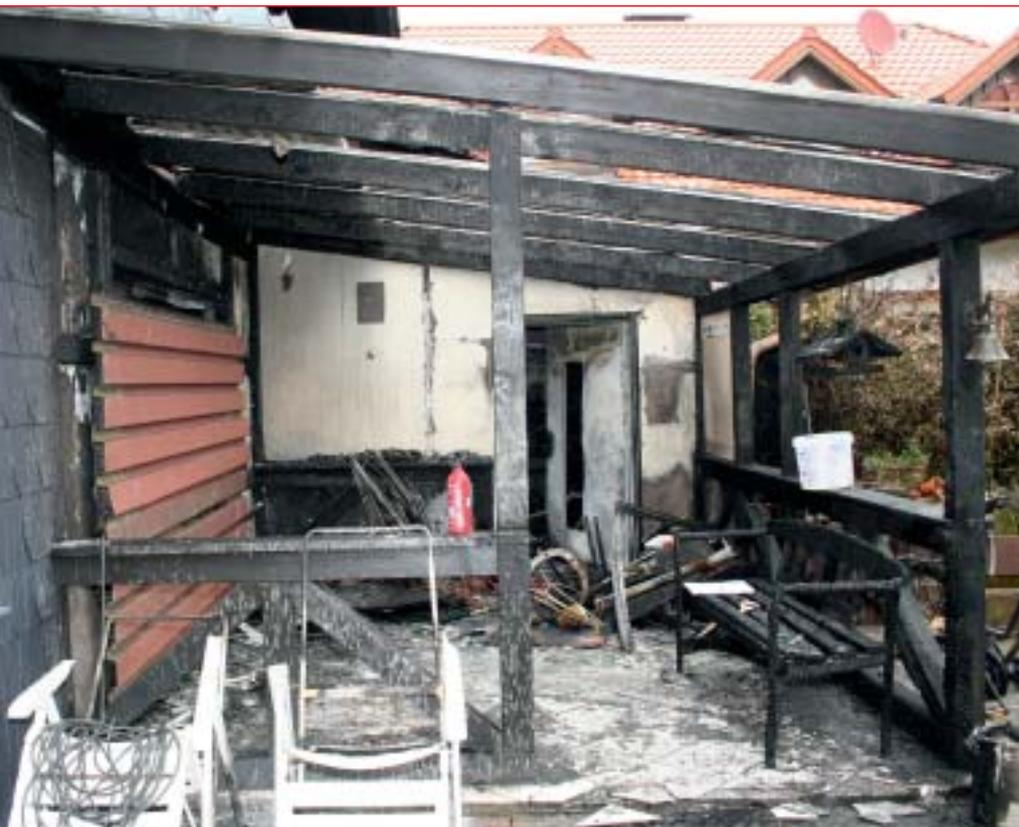
**Bild 1:** Eine Tür führt von der überdachten Terrasse in die Garage. Das Feuer hatte von der Garage auf die Terrasse und das Haus übergegriffen.
