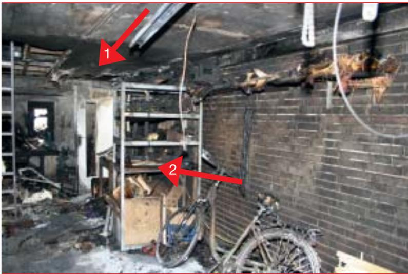
**Bild 2:** Die Schäden an der Deckenverkleidung nehmen nach hinten zu (1); in dem Regal (2) lagerten brennbare Materialien.
