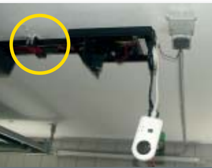
Bild 5, Bild 6: Der Kreis markiert Überschlagespuren von der Betonarmierung auf die Führungsschiene. In Bild 6 ist die abgesprengte Platine ersichtlich. Der in der Steckdose integrierte Überspannungsschutz und die Verkabelungen waren unbeschädigt.
