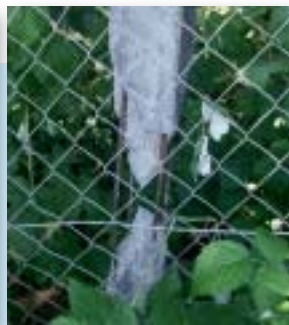
Bild 9, Bild 10: Überschlagsstelle am Zaunpfiler mit markanten Betonabplatzungen: Die Blitzströme wurden über den Maschendrahtzaun zur Garage weitergeleitet.
