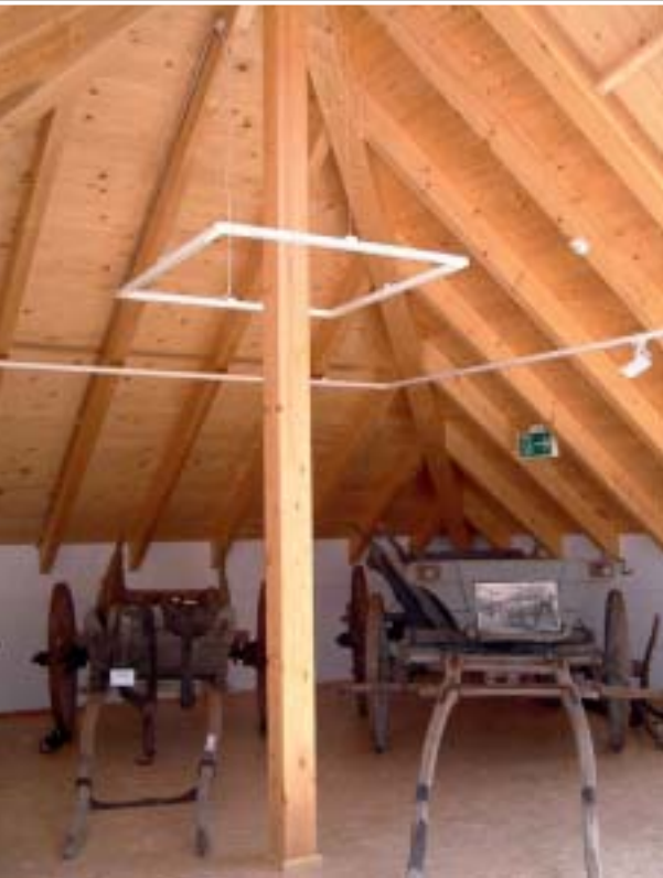
Bild 2 | Häufig treffen hohe Brandlasten von Gebäude und Ausstellung aufeinander. In Abhängigkeit von örtlichen Gegebenheiten und den ausgestellten Werten sind die erforderlichen Sicherheitsmaßnahmen abzuwägen.
