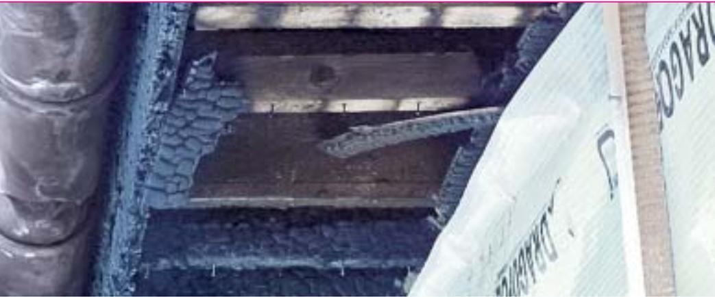
**Bild 1** | Brandschädigung Traufe – Brandweiterleitung über Fensteröffnung
