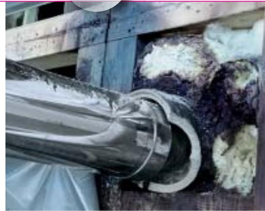
**Bild 2** | Unsachgemäß angeschlossenes Kaminrohr
