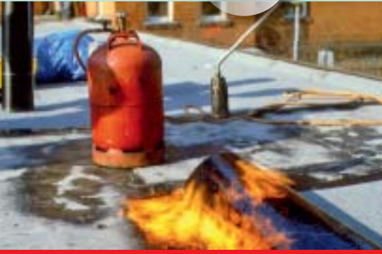
Bild 3 | Feuergefährliche Arbeiten, Quelle: VdS 2216
