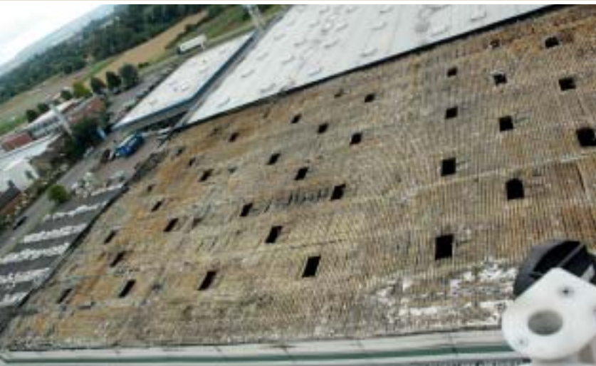
Bild 2 | Blick von der Drehleiter auf das Dach
