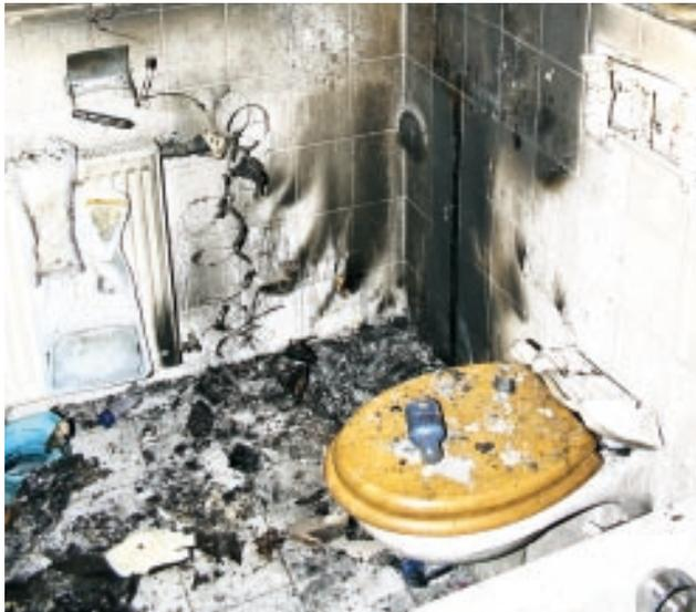
**Bild 8** | In dieser Ecke stand ursprünglich ein Wäschetrockner. Trotz eines eigentlich räumlich begrenzten Brandschadens belief sich die Schadenssumme auf etwa 15.000 €.
