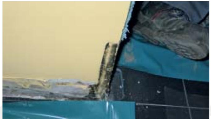
**Bild 8** | Die Durchfeuchtung im Fußboden zeigte sich erst durch einen Schimmelpilzbefall an den Leichtbauwänden.
