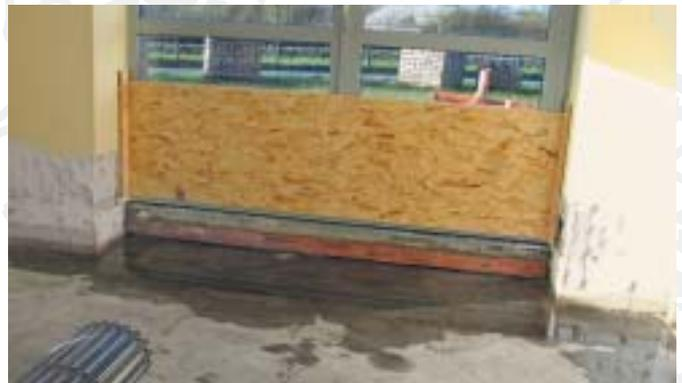
**Bild 9** | Nach dem Rückbau des Fußbodenaufbaus wird der massive Wassereintrich ins Terminalgebäude deutlich.
