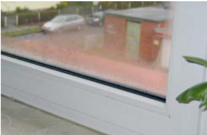
**Bild 2** | Die massive Kondenswasserbildung an einem Fenster durch mangelhafte Lüftung
