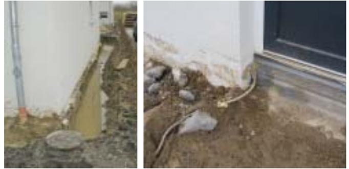
**Bild 6, 7** | Das am Gebäude anstehende Wasser konnte nicht abfließen. Durch unzureichende Abdichtung der Durchführungen drang die Feuchtigkeit ins Gebäude ein.
