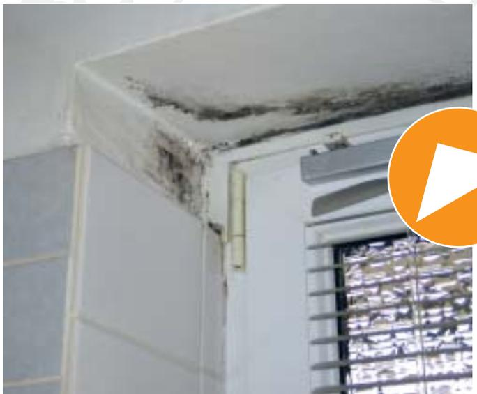
**Bild 3** | Der starke Wärmeverlust am Fenstersturz führt zur Kondenswasserbildung und zum Schimmelbefall.
