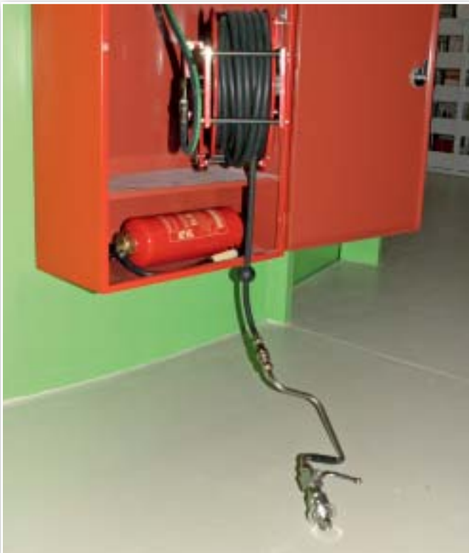
Bild 6 | Ungewöhnlich: Auch die Wandhydranten verfügen über einen Anschluss an das Hochdruck-Löschsystem. Die Gehäuse hätten die Architekten gerne ihrer Farbgestaltung angepasst. Sie quasi unsichtbar zu machen, ließ sich mit den Richtlinien nicht vereinbaren.
