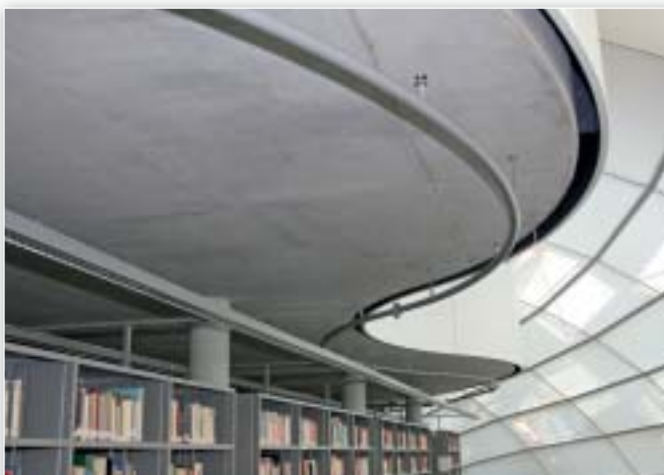
Bild 9 | Die Löschwasserleitungen der Sprinkleranlage verlaufen nicht nur parallel zu den Bücherregalen, sondern auch entlang der geschwungenen Konturen der einzelnen Etagen.
