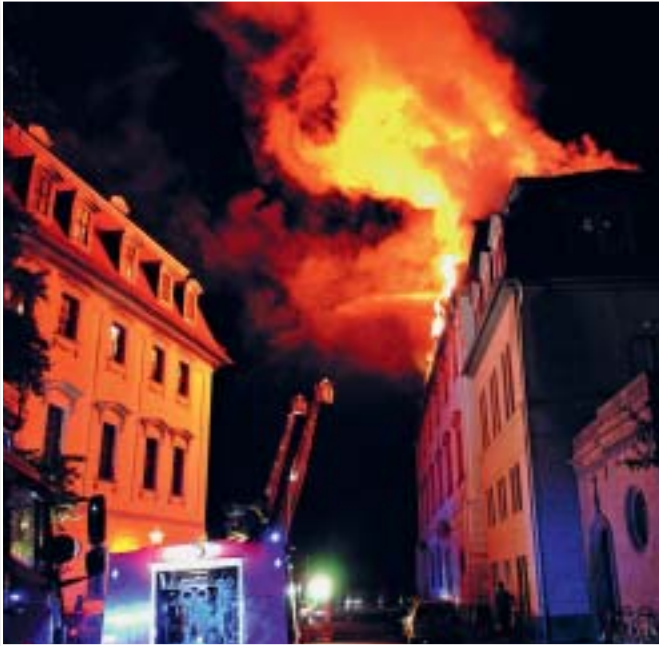
Bild 1 | Nicht nur die Bausubstanz trug starke Schäden davon. Damals verbrannten vor allem Bücher und Kunstwerke von unschätzbarem Wert. (Foto: Stiftung Klassik, Weimar).
