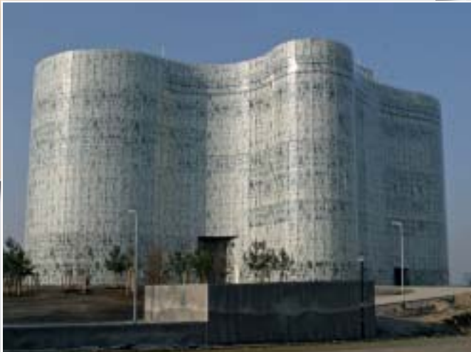
Bild 3 | Aufgrund der ungewöhnlichen Architektur ist das Gebäude mit dem Deutschen Architekturpreis geehrt worden. Das oberirdische Gebäudeteil besteht, abgesehen von den Treppenhäusern, nur aus drei Brandabschnitten: 7. OG (Verwaltung), EG bis 6. OG und Cafeteria.
