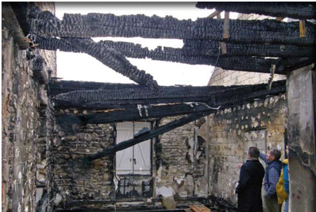
Bild 1 | Über diesem Bereich waren die Module montiert.
