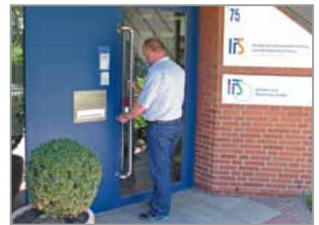
Bild 4 | Außerhalb der Arbeitszeit wird mit einem Blockschloss die Gefahrenmeldeanlage aktiviert. Die Wasserinstallation wird automatisch abgesperrt.
