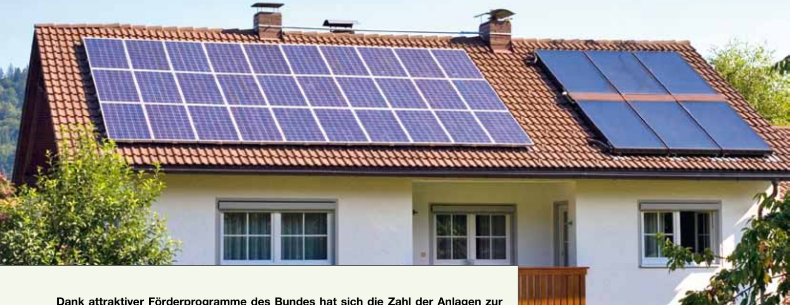
Bild 1 | Gebäude mit Solarkollektoren (rechts) und Photovoltaikmodulen (links)
