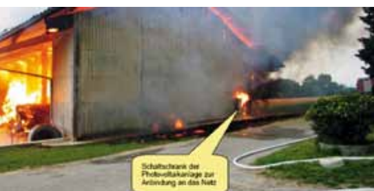
Brennender PV-Schaltschrank, Quelle: HDI-Gerling
