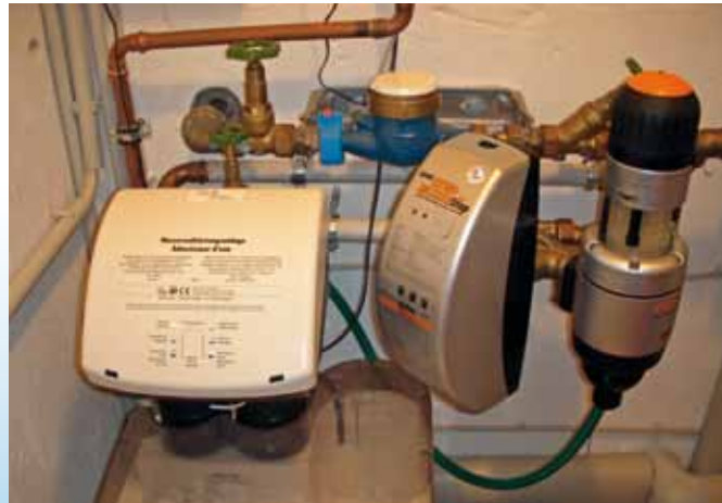
Bild 1 | Einbausituation des ZEW-WASSERSTOP (Bildmitte) in einem Einfamilienhaus. Links im Bild ist die Ionenaustauscheranlage zur Wasserenthärtung erkennbar. Rechts im Bild ein Feinfilter, der in keiner Leitungswasserinstallation fehlen darf.
