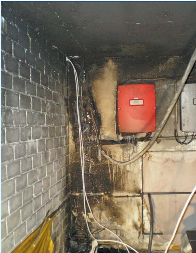
**Bild 4** | Brand der Unterverteilung Wechselrichter und der DC-Kabel.
