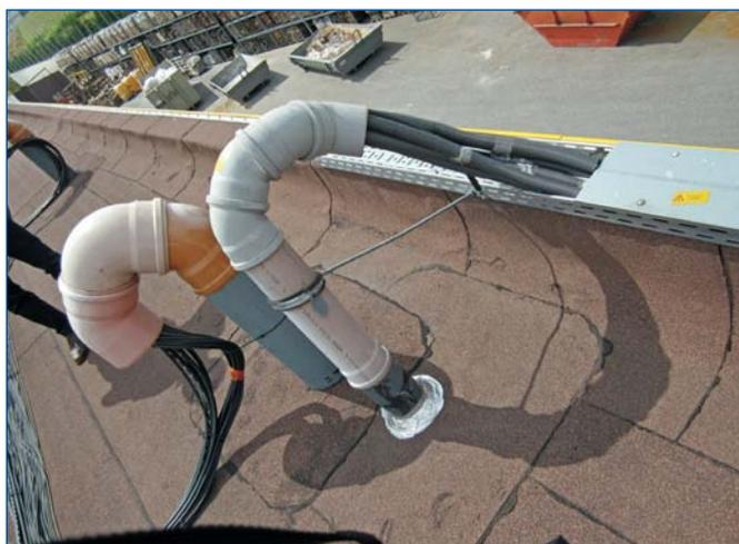
**Bild 11** | Gefahrenquelle beim Löscheinsatz: Die Dachdurchführungen der PV-Kabel und der 20kV-Hochspannungskabel befinden sich ungekennzeichnet direkt nebeneinander!
