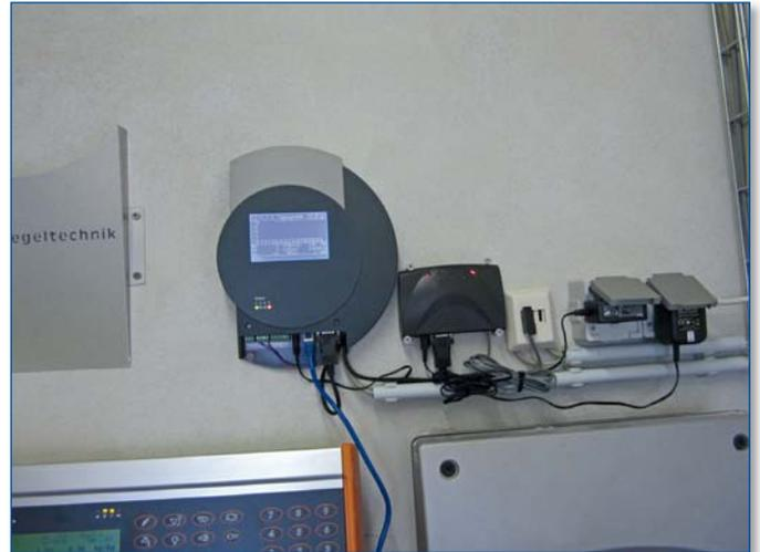
**Bild 5** | Gegen Überspannung ungeschützte Datenerfassung und Weiterleitung.
