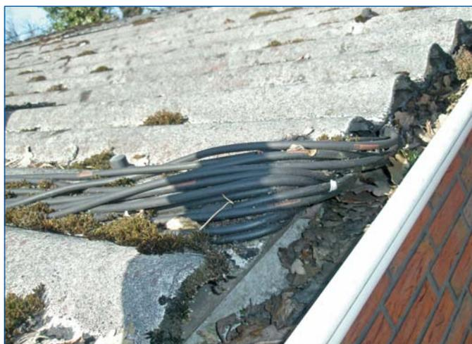
**Bild 9** | Nicht fachgerechte Kabelführung: Befestigung, Kantenschutz fehlt.
