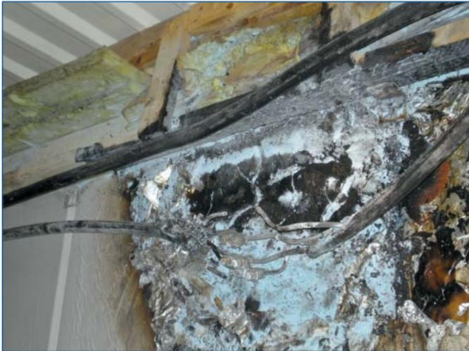
**Bild 3** | Brand eines AC-Kabels durch nicht fachgerecht ausgeführte AL-Klemmverbindung.
