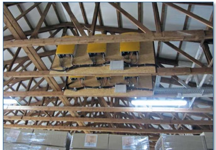
**Bild 6** | Installation der Wechselrichter über brennbarem Lagergut.
