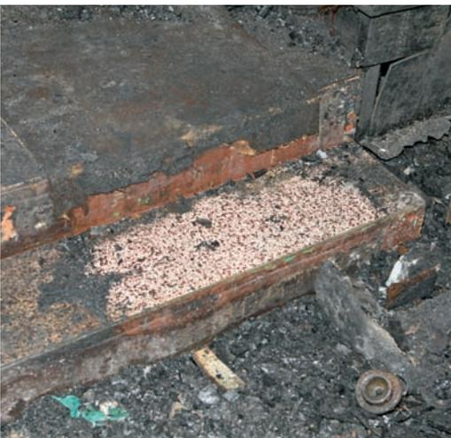
**Bild 2** | Lachenförmige Spur auf dem Teppichbelag der Stufe
