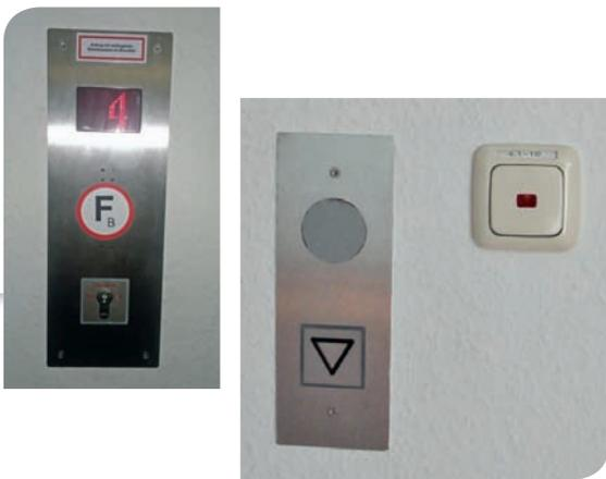
**Bild 3** | Unteres Tableau mit der „provisorischen“ Unkenntlichmachung der Standardausschilderung „Aufzug im Brandfall nicht benutzen“
