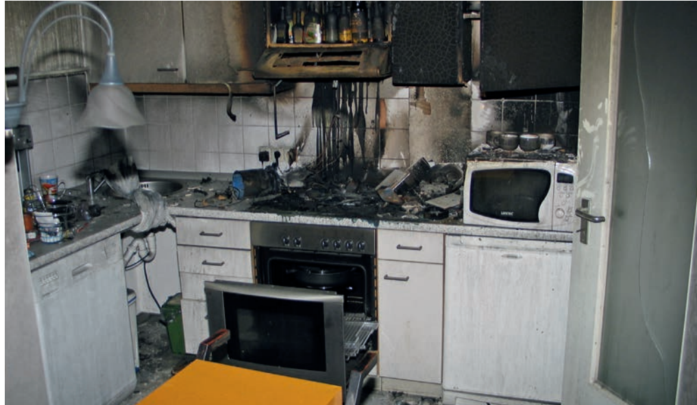
Bild 2 | Die Überreste eines Wasserkochers und einer Kaffeemaschine liegen im unmittelbaren Bereich des Cerankochfeldes. Hier ist der Brand eindeutig entstanden.
