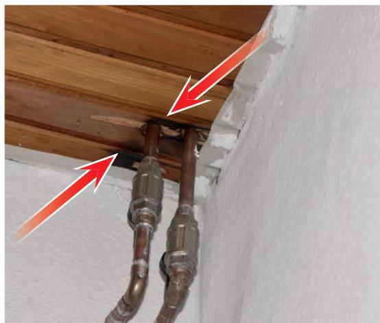
**Bild 1** | Schadensschwerpunkt in der Dachgeschosswohnung: Ausgehend von der Lötstelle nehmen die Brandschäden ab.
