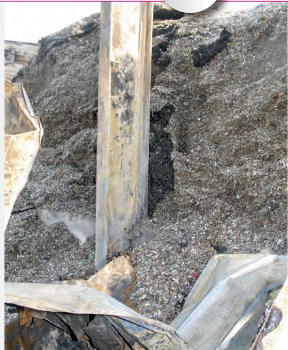
**Bild 12** | Neben einem Pfeiler zeigen sich markante Brandzehrungen an dem Recyclingmaterial.
