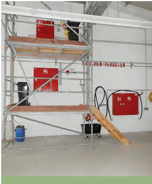
Bild 3 | Übungsanlage – Wandhydranten und Trockensteigleitung Bild 4 | Übungsmodelle für Brandschutztüren
