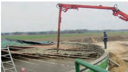
**Bild 9** | Schwimmschichtbildung, die durch eine Rührwerkshavarie entstanden ist.
