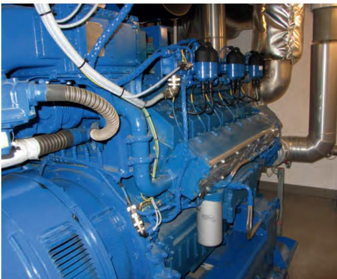
**Bild 6** | Gasmotor mit einer Leistung von 500 kW
