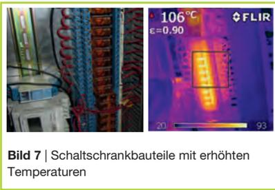
**Bild 7** | Schaltschrankbauteile mit erhöhten Temperaturen
