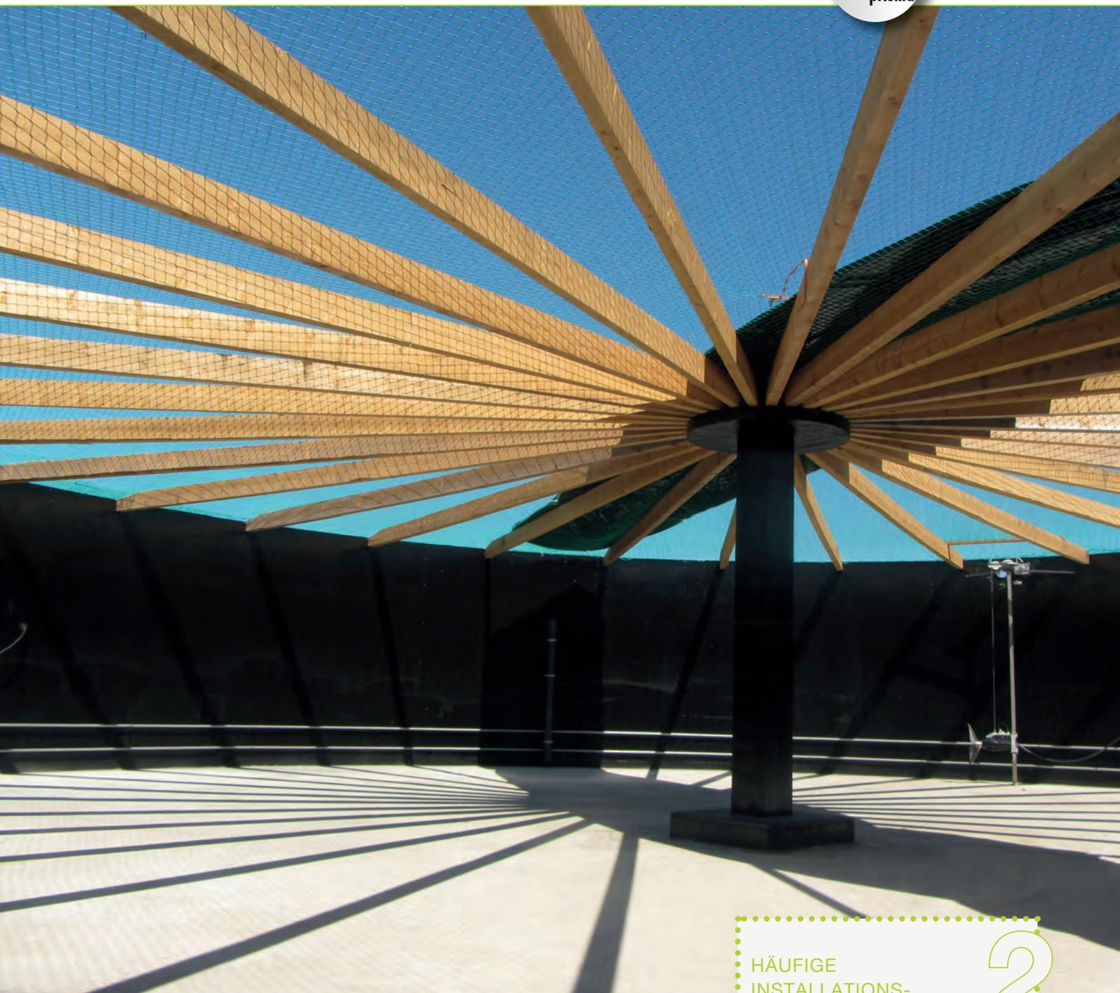
**Bild 10** | Innenansicht eines typischen Behälters mit „Aufputz-Beheizung“
