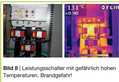
**Bild 8** | Leistungsschalter mit gefährlich hohen Temperaturen. Brandgefahr!
